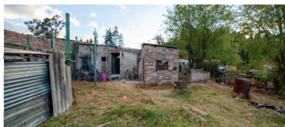
Lote antes de la construcción
